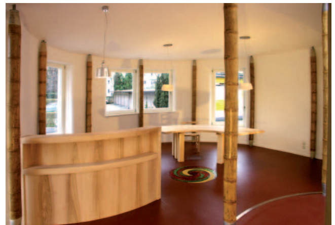
Innenansicht eines Bürogebäudes mit tragenden Bambusstützen, Quelle: www.ShaktiHaus.de
