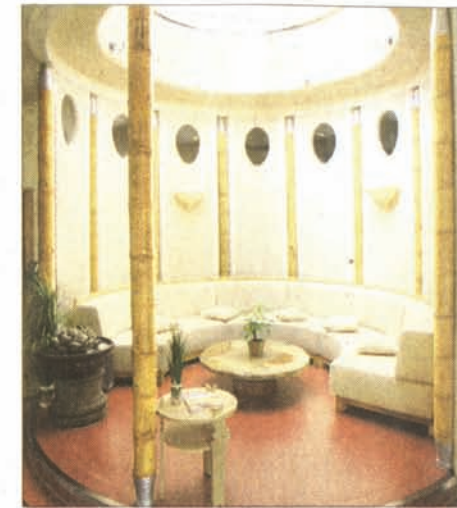
Funktional und dekorativ zugleich sind die 33 Bambus-Stützen, die das einstöckige Bürogebäude in Darmstadt tragen. Bambuspfeiler umrahmen die Rotunde mit Sitzgruppe im Inneren – so entsteht eine freundliche Raumatmosphäre. Fotos: Shakti Haus
