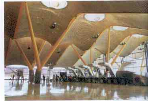
Deckenkonstruktion unter Einsatz von Bambusholz am Flughafen in Madrid (Quelle: Moso®)
