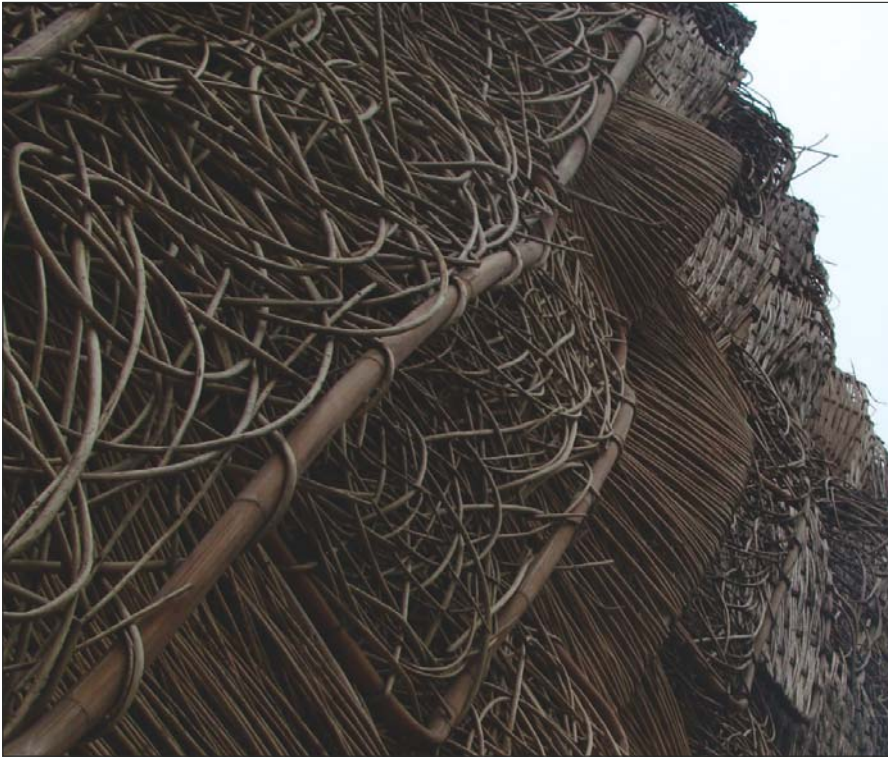
Rattan-Fassade des spanischen Pavillons.
