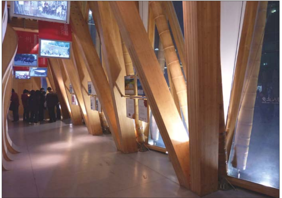
Leimbambusbinder im Erdgeschoss des Deutschland- und China-Hauses.
